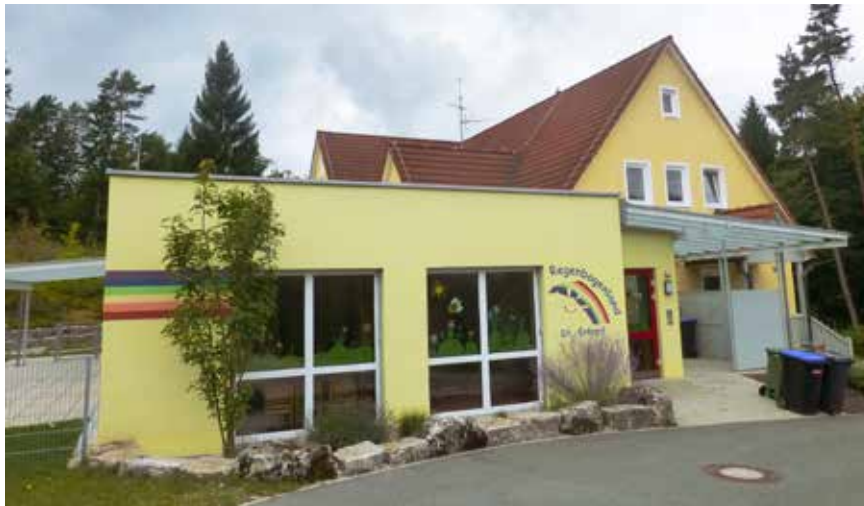
Abbildung Kindergarten „St. Erhard“ in Wichsenstein
